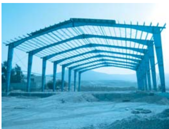
نمای کلی سازه سوله
