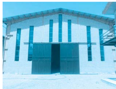
استفاده از دیوار آجری سنگین در کل ارتفاع
