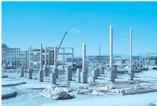
اجرای ستونک‌های بتنی (پداستال)
