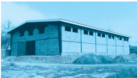
استفاده از بلوک سیمانی در دیواره‌ها
