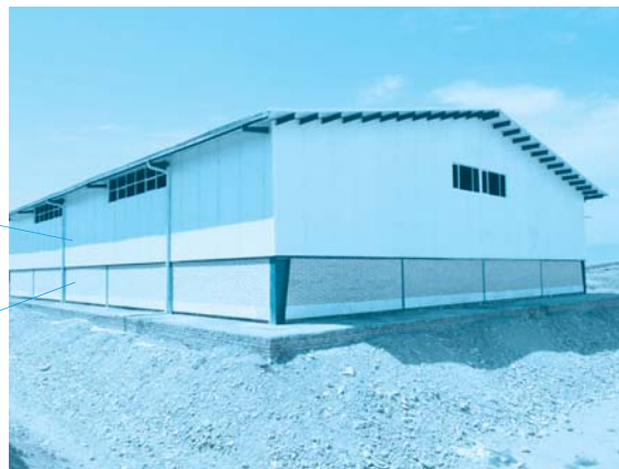
استفاده ترکیبی از دیوار سنگین و دیوار سبک ساندویچ پانل در ارتفاع سوله
