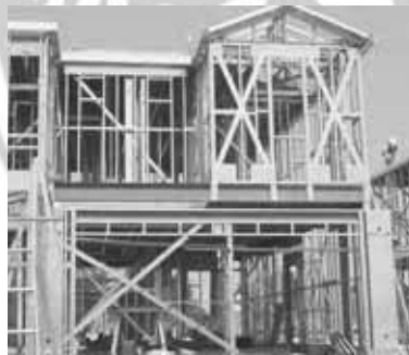
شکل ۴۶: استفاده از دهانه‌های مهاربندی شده یا صفحات پوششی فولادی برای پایداری جانبی سیستم LSF
