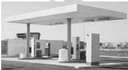
شکل ۴۹: سازه یک پمپ بنزین با سیستم کنسولی
