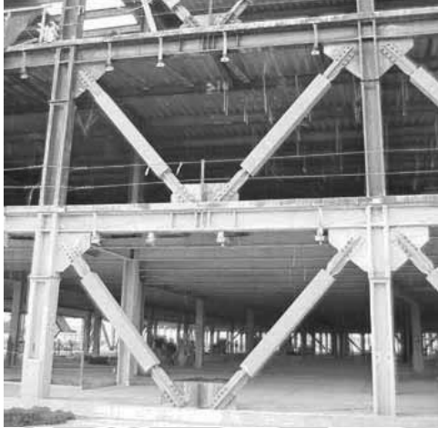
شکل ۳۴: کاربرد مهاربندهای کمانش‌تاب
