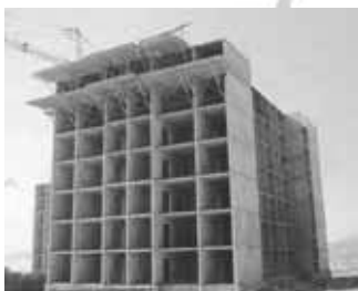
شکل ۷: ساختمان با سیستم قالب تونلی
