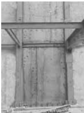
شکل ۱۰: نمونه‌ای از کاربرد دیوار برشی فولادی
