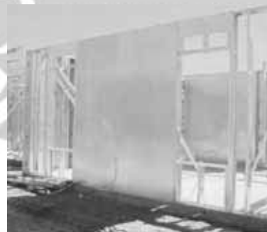
شکل ۴۶: استفاده از دهانه‌های مهاربندی شده یا صفحات پوششی فولادی برای پایداری جانبی سیستم LSF
