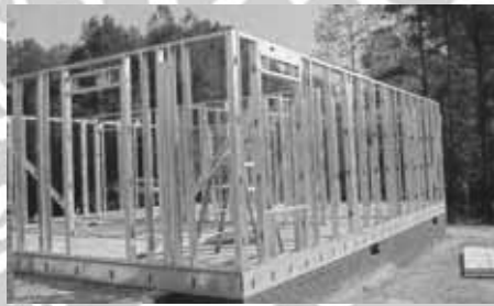
شکل ۴۵: یک سازه در حال ساخت با سیستم LSF
